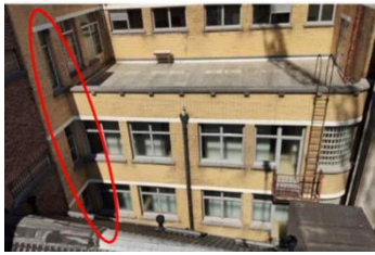
Façade sur cour avec indication de la travée à démolir pour la construction d'un mur rideau vitré – photo extr. du dossier de demande
