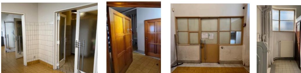
Exemples d'éléments de menuiserie d'origine présents dans l'immeuble (photos extr. du dossier de demande)
