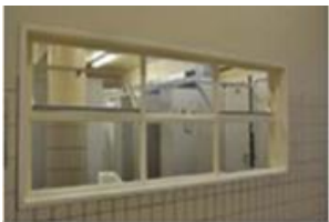
Ex. d'une baie supprimée par l'installation du 2 e ascenseur – extr. du dossier de demande
