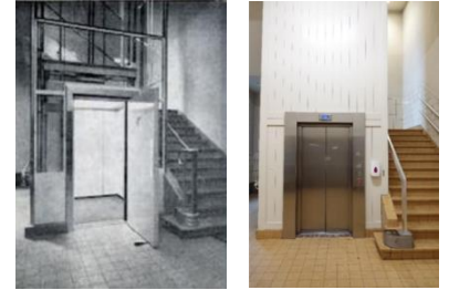
Photo historique de l'ascenseur d'origine et photo de l'ascenseur existant – extr. du dossier de demande
