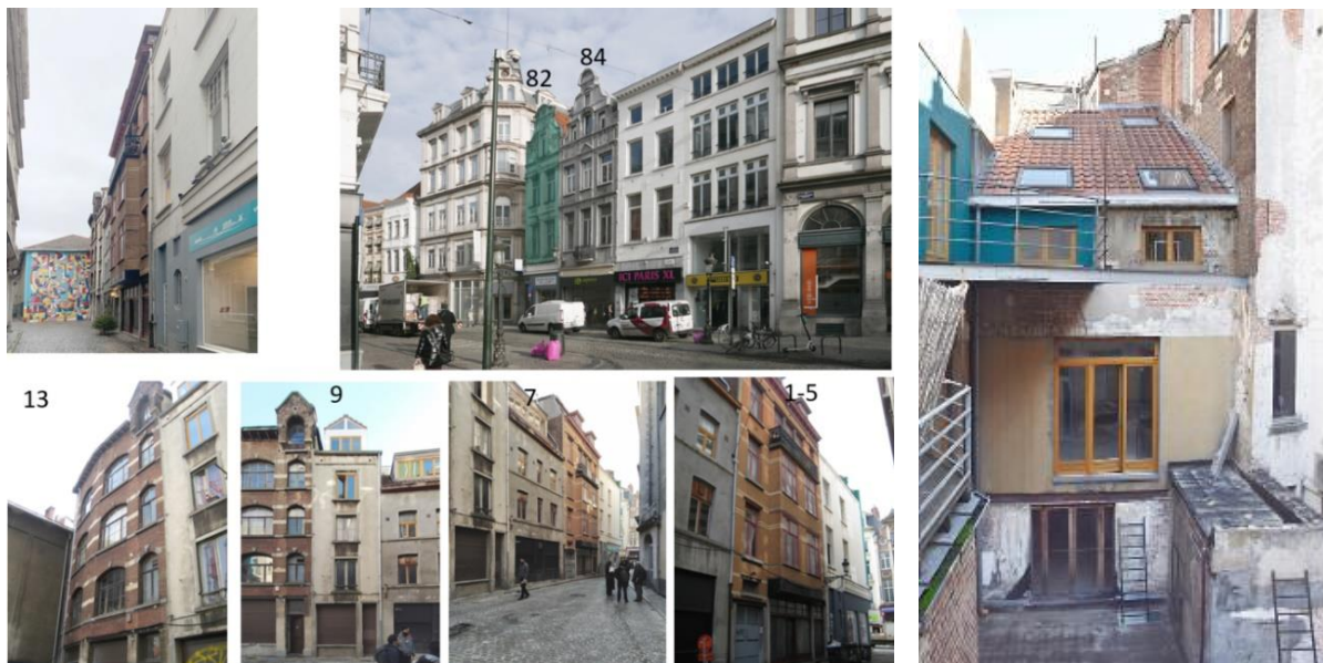
Façades à rue et sur cour (photos jointes à la demande)
