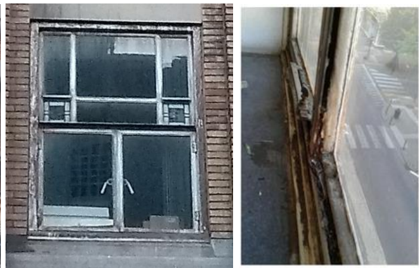
Exemples pathologies châssis acier (images extraites du dossier)
