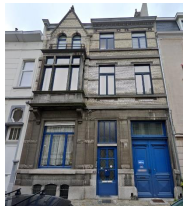
Bestaande toestand van de voorgevel (© Google Streetview)
