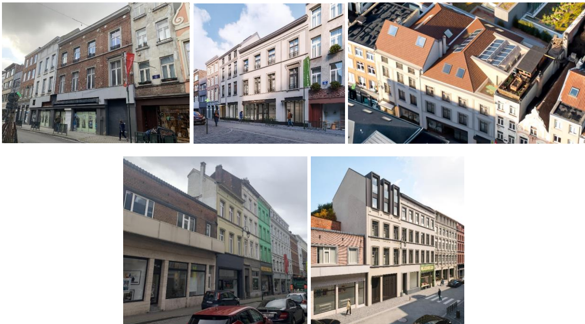
Maisons rue Haute (dessus) et rue Blaes (dessous) : photos de l'état existant et photomontages de l'état projeté, jointes à la demande
