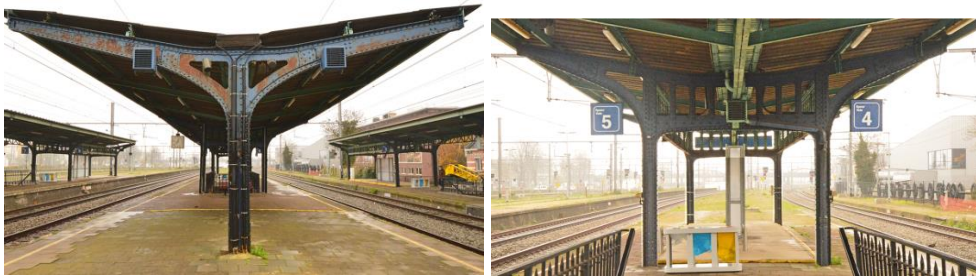
Portiques simples et doubles, état existant, photos jointes à la demande
