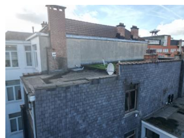
Toiture du bâtiment (Photographie extraite du dossier de demande)
