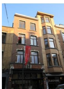
Façade avant (Photographie CRMS)
