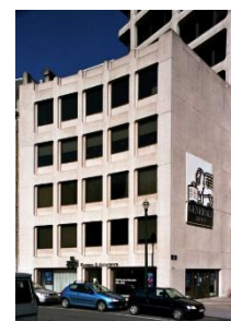
Immeuble face au Bois de la Cambre (Inventaire)
