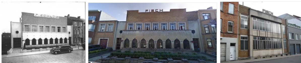
Oorspronkelijke en huidige gevel aan de E. Rostandstraat en bestaande gevel aan de Scheutlaan (© Brugis en © Google Streetview)
