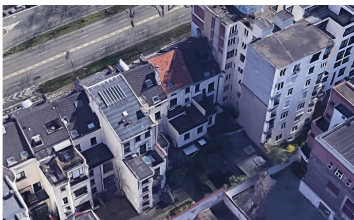
Vue aérienne de l'intérieur d'îlot (avant travaux) © Google Street View
