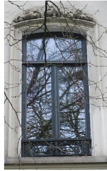
Photo d'un des châssis du 1 er étage. Photo CRMS 2024
