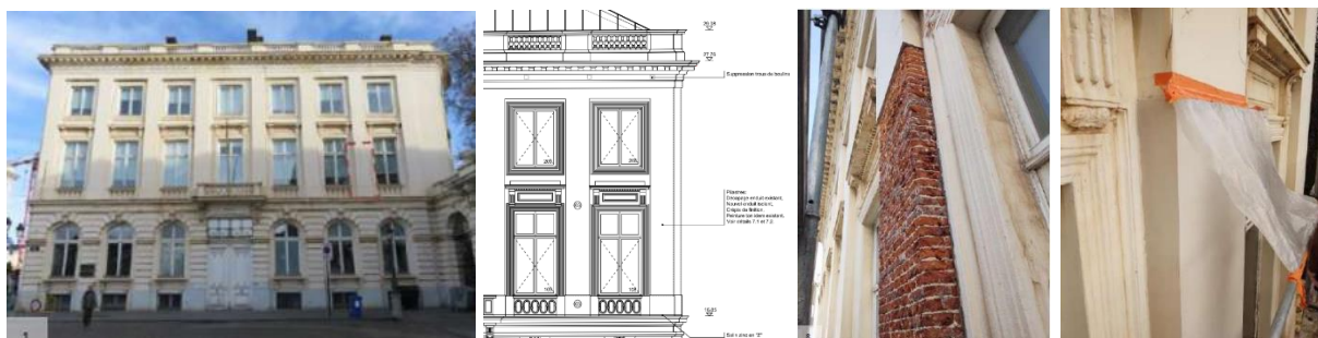
Dérochage de l'enduit ciment existant et application d'un enduit thermo-isolant (chantier test) : Documents extraits du dossier
